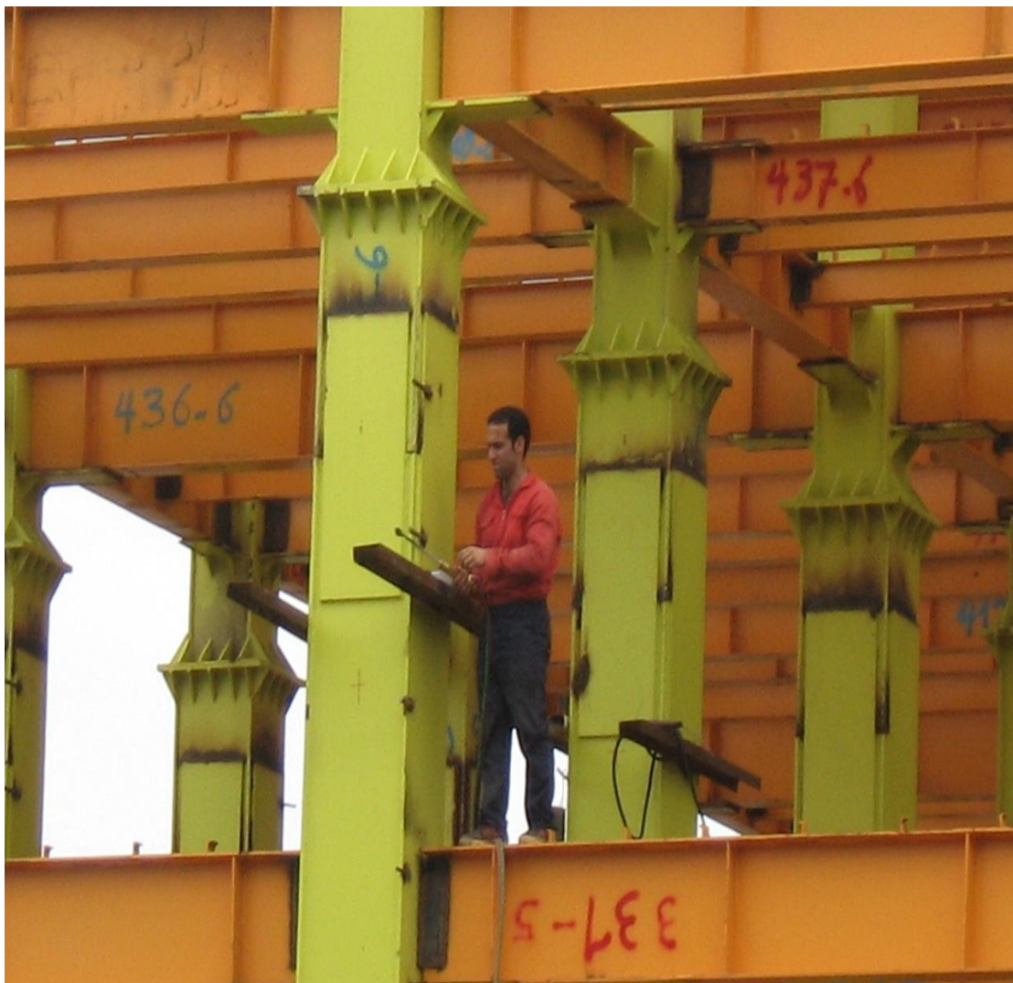
تقلیل ضخامت ستون فلزی
